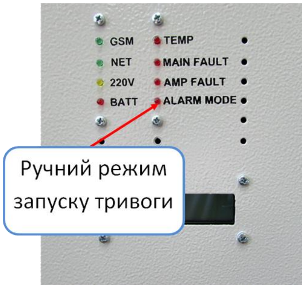
Малюнок 1.1.1.1 Індикація ручного режиму на дверцятах моноблоку Сола
